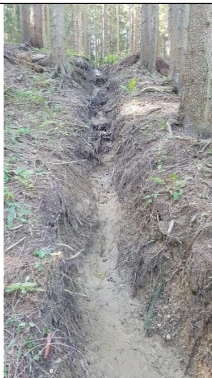
Slika 3. Površinski jarki, izvedeni v zgornjem delu plazu Betel (Jesenice, Slovenija) (Arhiv GeoZS).
