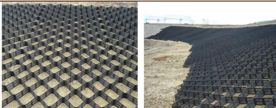
Obr. 7. Ochrana svahů usazovací pánve cukrovaru v Dobrovici (Česká republika) geobuňkami
