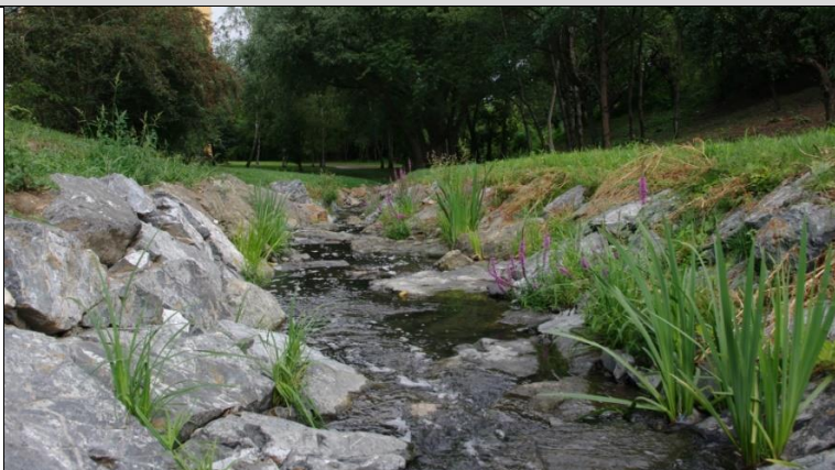
Obr. 10. Kamenný pohoz s vegetací v korytě Chodoveckého potoka, Česko (zdroj: https://www.prostranstvi.cz/Priklady-dobre-praxe/Databaze/Revitalizace-vodnich-toku-ve-meste )
